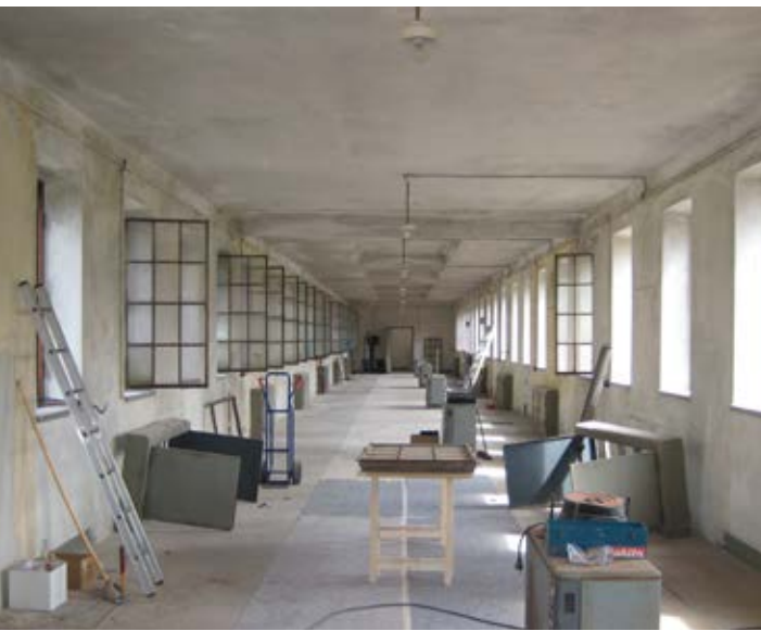
Renovierung des Umspannwerkes, Foto: Sebastian Kruse
