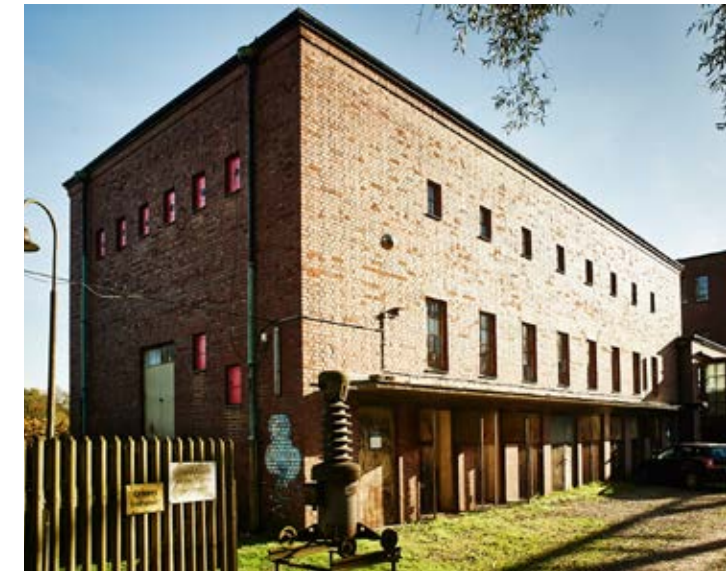
Ehemals Umspannwerk, heute Ort für Kreative.
